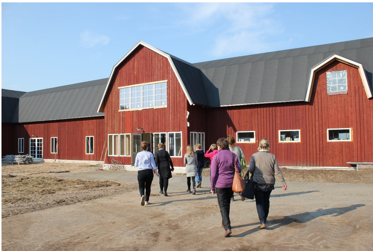
Bondgården Bäligenin navetassa on meneillään perusteellinen remontti. (Kuva: Anne Tuomivaara)
