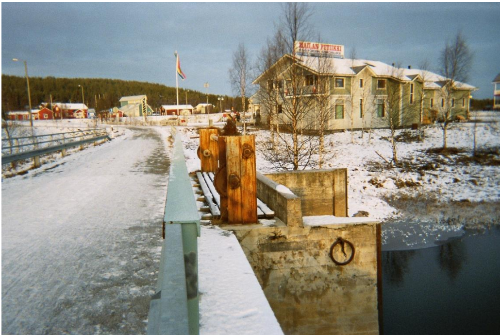
Kuva 9. Äkäsjoen vanha sulku.
