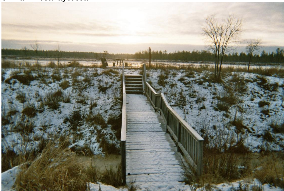
Kuva 3. Ylläslompolon lintutornin reittirakenteita.
